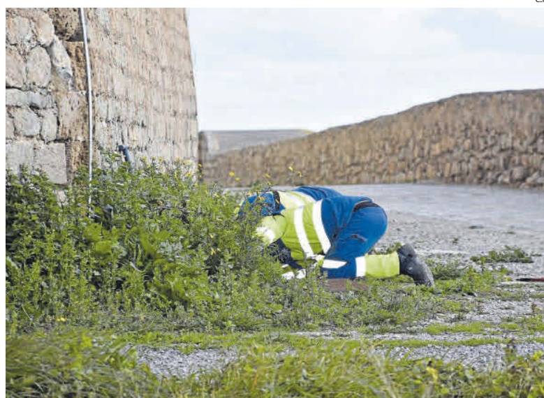
Operarios inspeccionan un tramo de la canalización junto a la puerta del Parador que da a la ronda Calvi.
