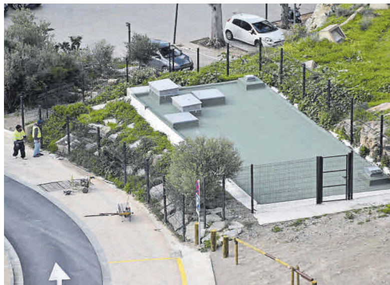
Trabajadores de Aqualia junto al depósito, con su nuevo vallado.
