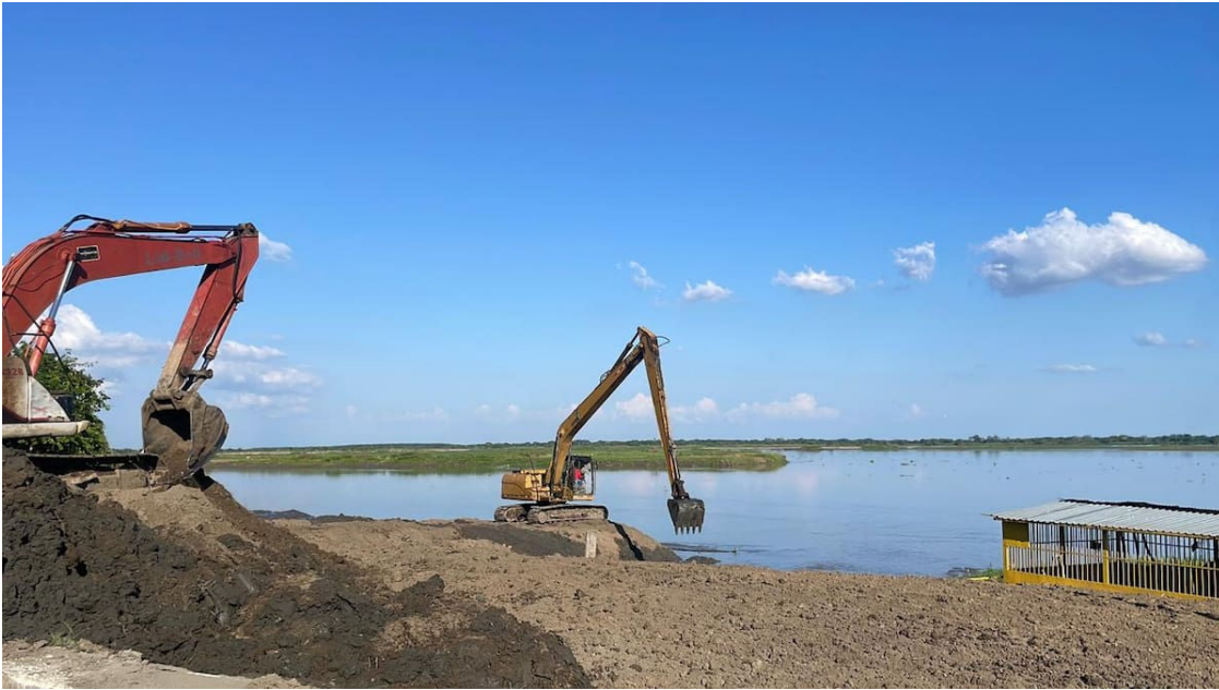
Obras de mitigación que se adelantan en Campo de la Cruz.
